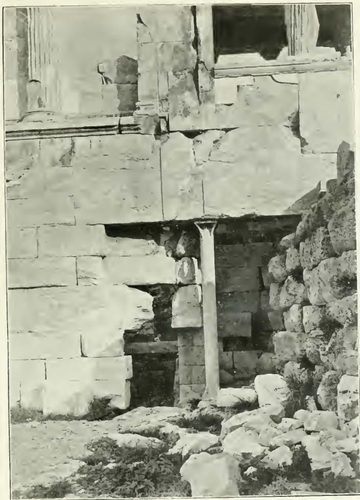
PARTIE SUD DU MUR OCCIDENTAL DE L'ÉRECHTHEION.
